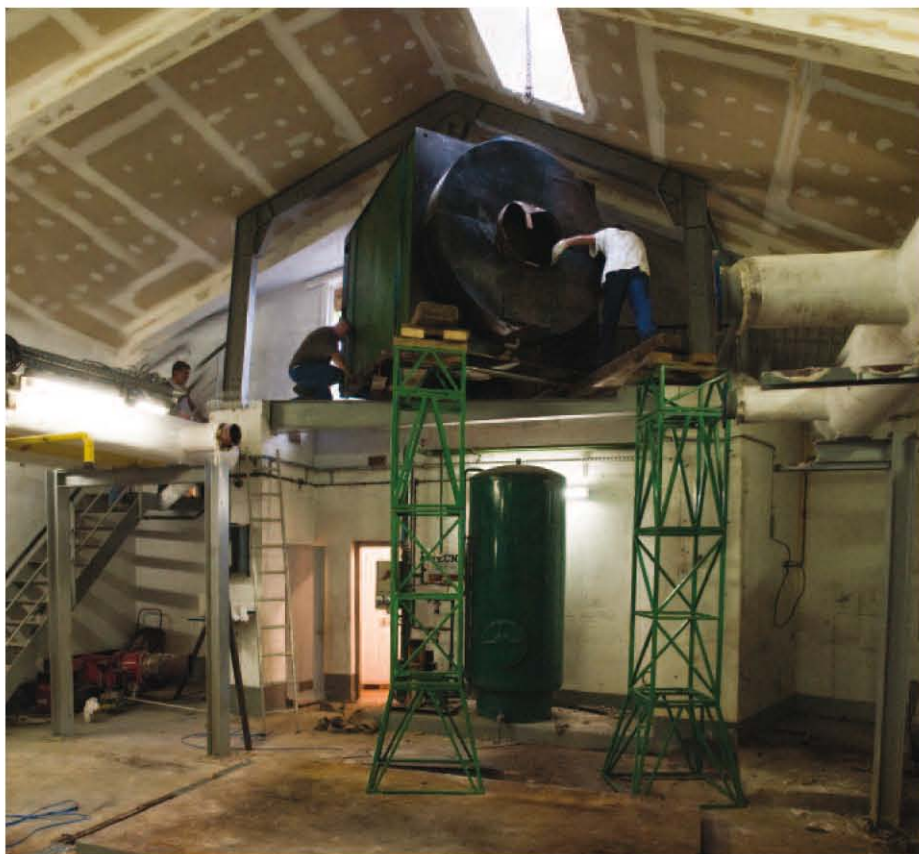
Provinces Françaises : Enlèvement de l'ancienne chaudière ▲
