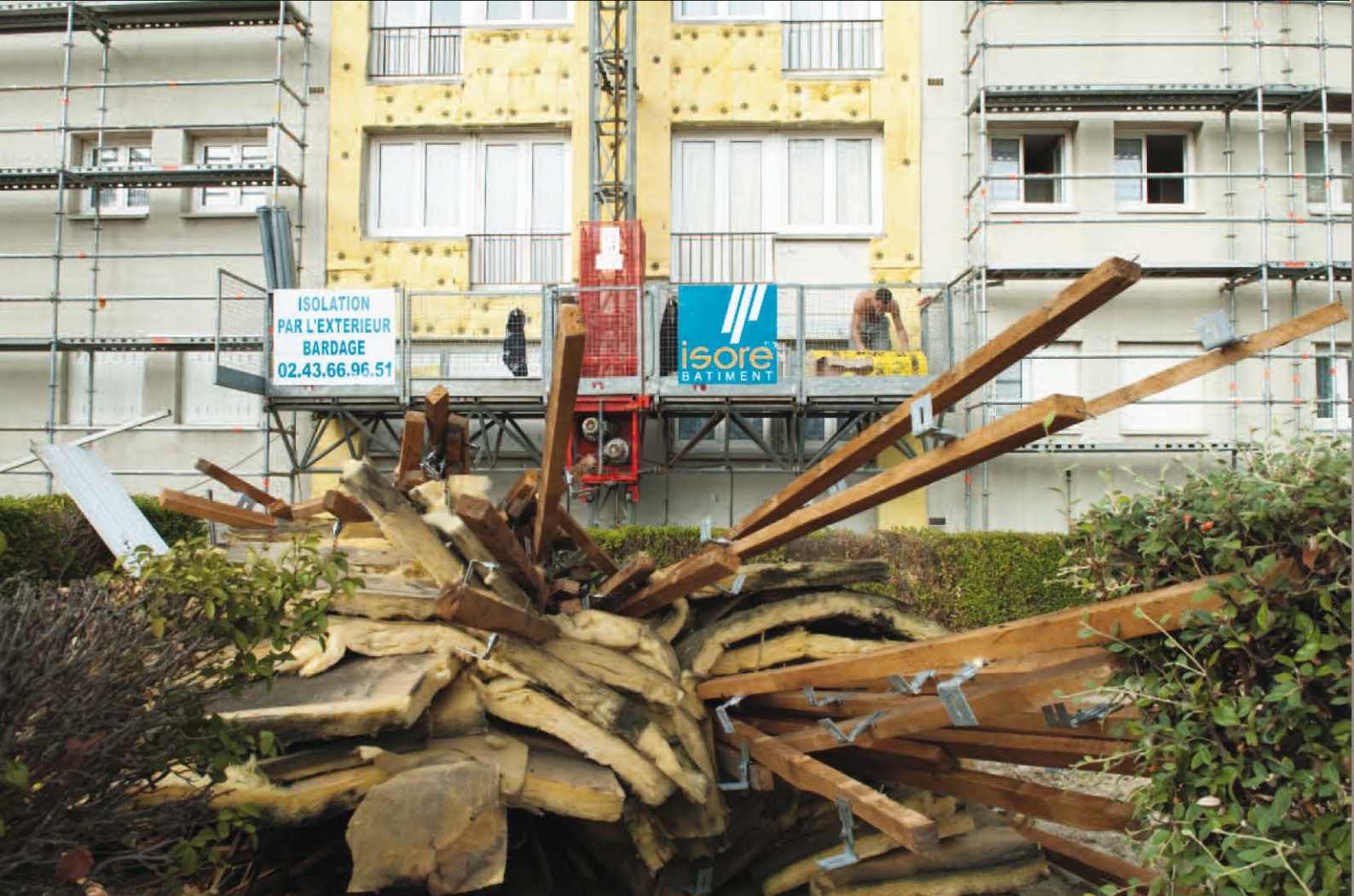
Petit Nanterre : Remplacement de l'isolation thermique ▲
