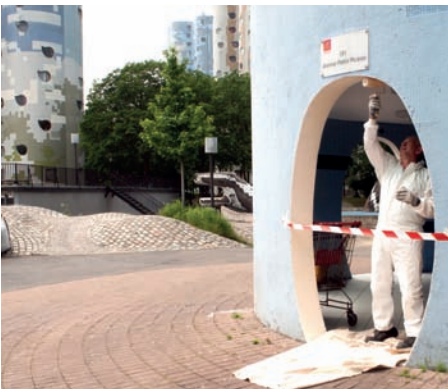
Travaux d'entretien aux Tours Aillaud.
