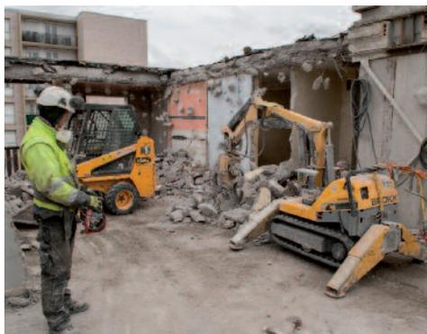
À l'heure où nous bouclons ce numéro, la déconstruction partielle du 2 résidence des Tulipes a déjà commencé. La cage d'escalier a été "attaquée" par le dernier niveau. Après la phase de curage (enlèvement des fenêtres, certaines cloisons...), c'est au tour des planchers.
