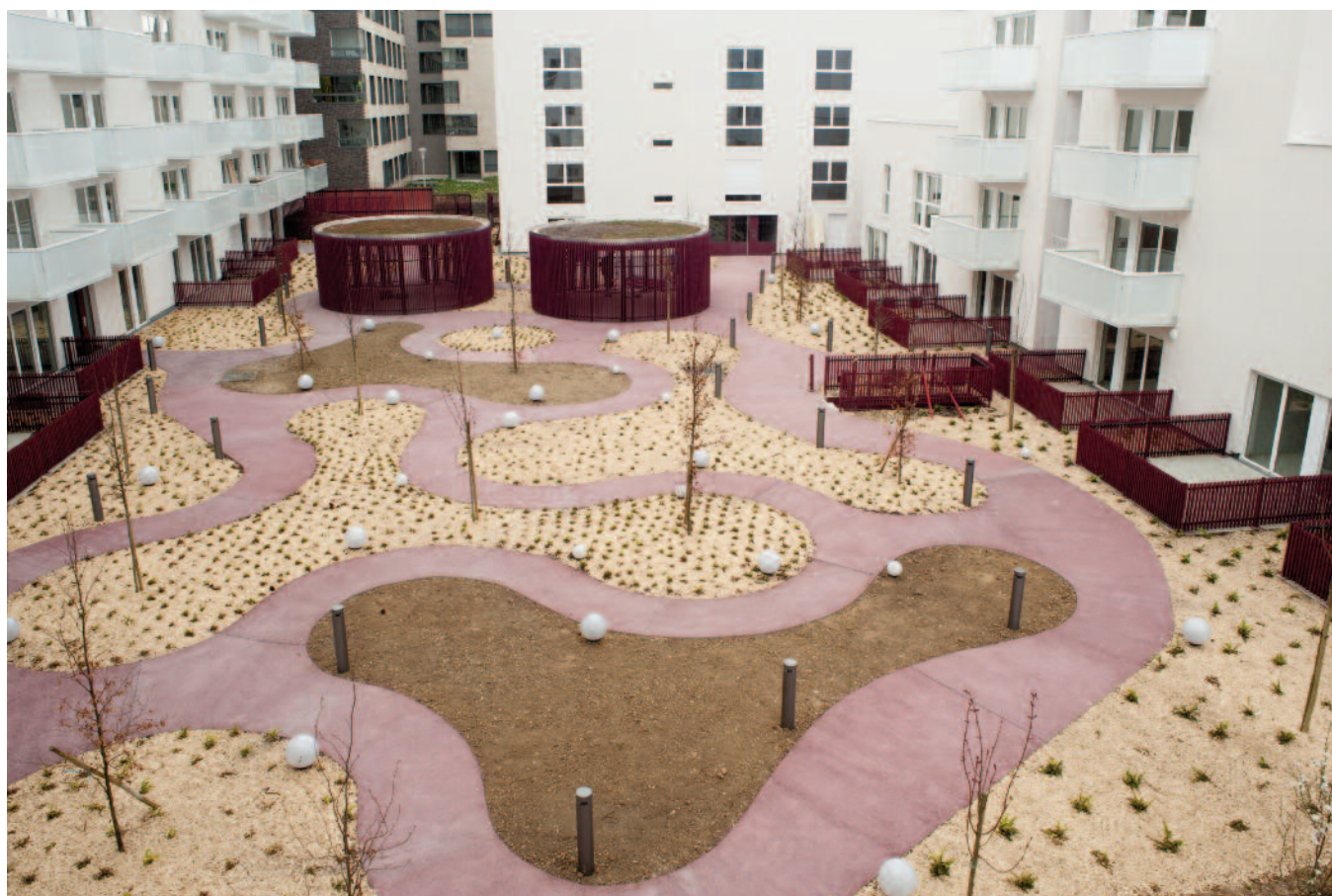
La nouvelle résidence Hoche-Doucet au Chemin de l'Ile
