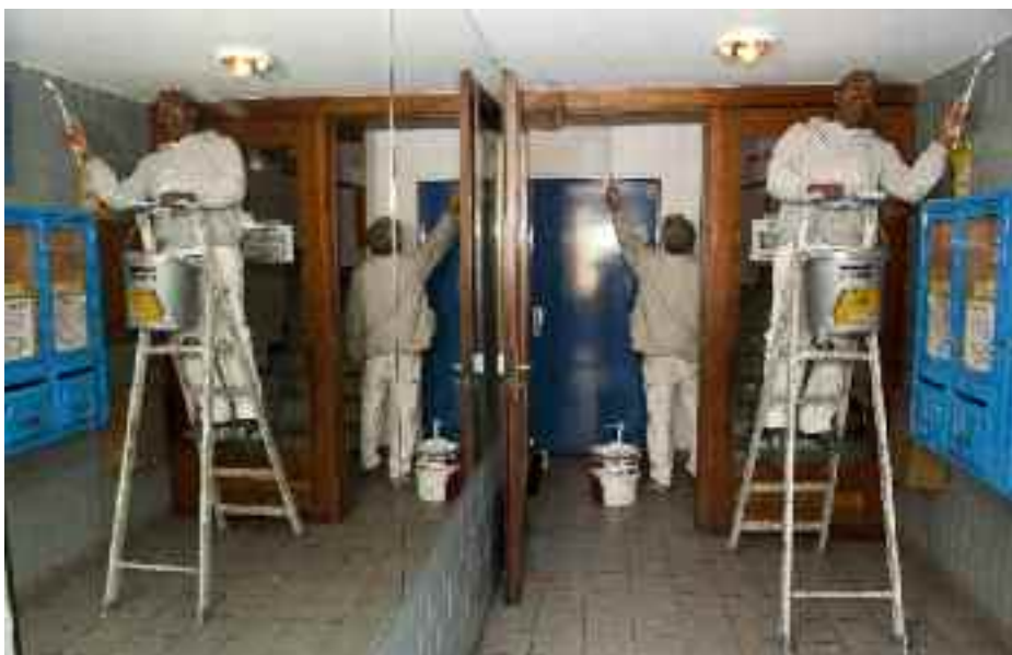
Mise en peinture d'un hall au Petit Nanterre ▲
