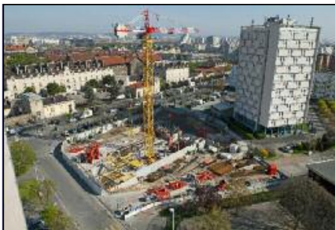
▲ ANRU PETIT NANTERRE, une vue des fondations du futur immeuble qui comprendra 29 logements pour l'Office (coté Canibouts).
