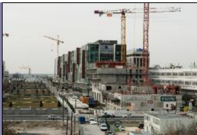
▲ TERRASSE 17 - une future construction de 58 logements bien avancée.
