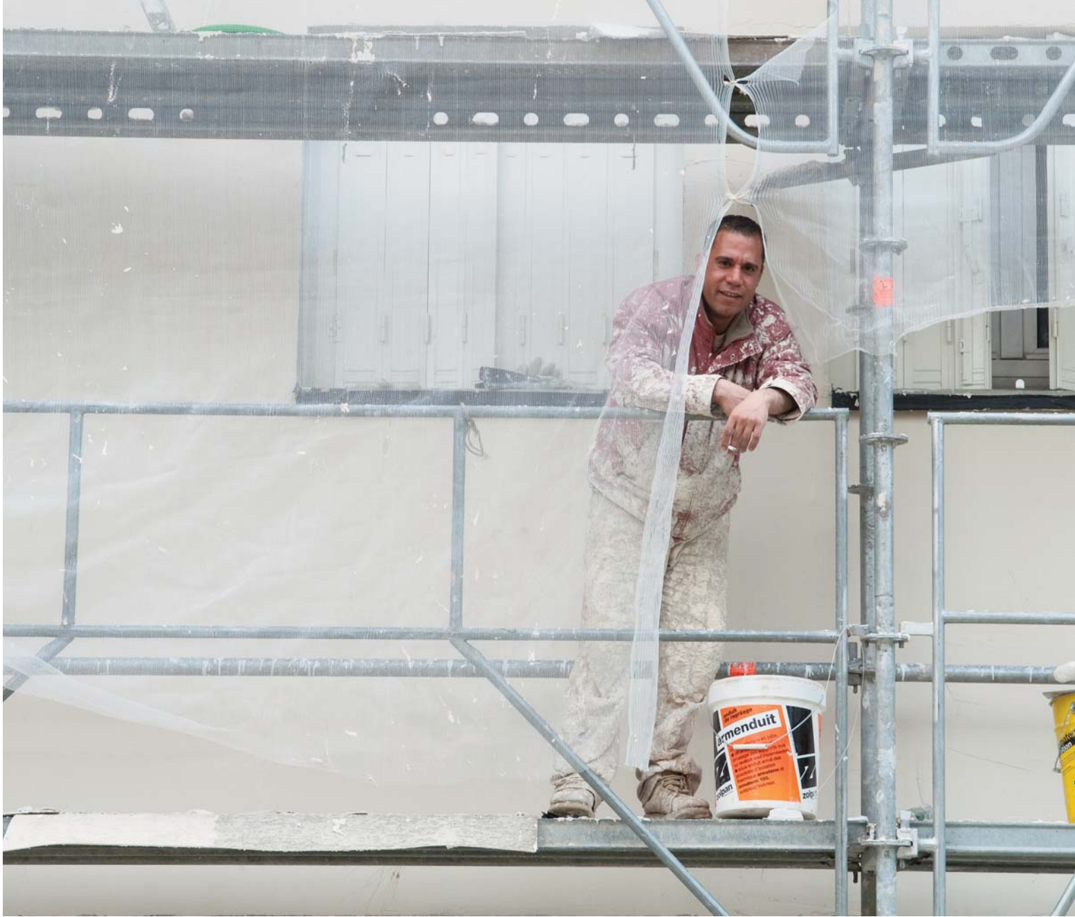
Petit Nanterre : rénovation des façades LOPOFA ▲
