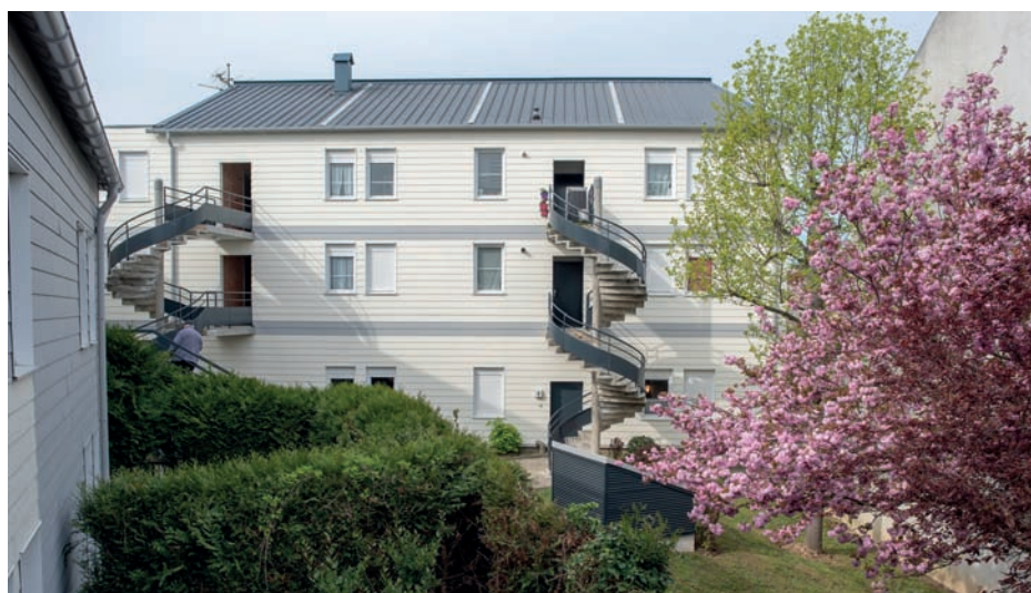
4 Chemins, après ravalement
